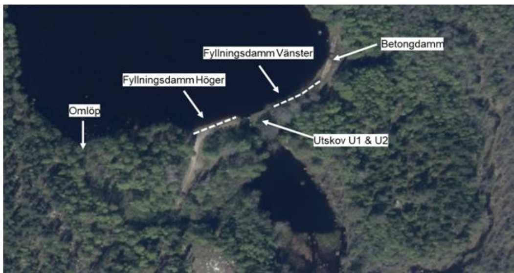
Figur 6.1. Översikt över Hålldammen och de olika anläggningsdelarna. © Lantmäteriet.
