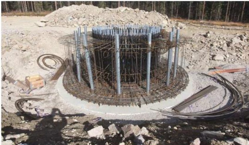
Figur 9. Byggnation av bergförankrat fundament vid Holmens vindkraftspark Blåbergsliden.
