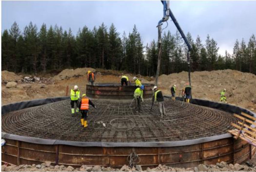
Figur 8. Byggnation av gravitationsfundament vid Holmens vindkraftspark Blåbergsliden. Här syns del av armeringen under pågående betonggjutning.
